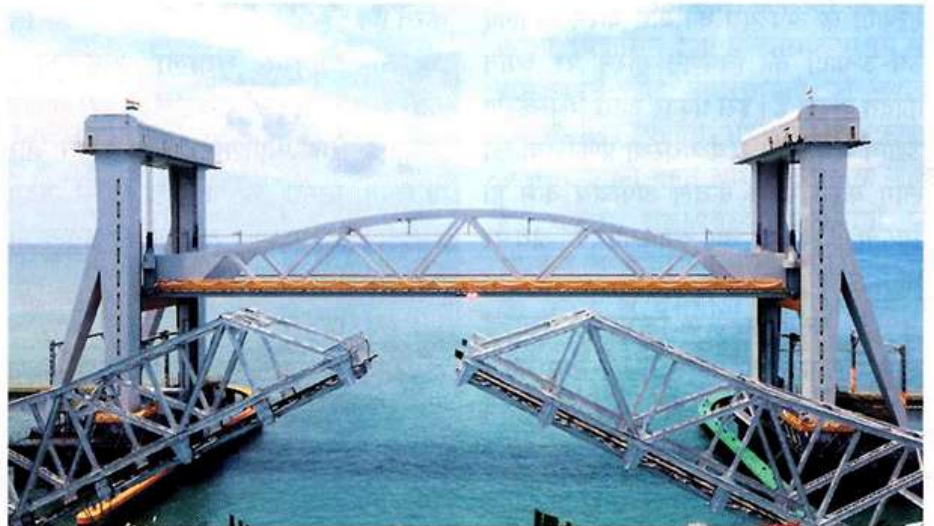
चित्र 1: रामेश्वरम में नए पम्बन ब्रिज का वर्टिकल लिफ्ट सेक्शन
