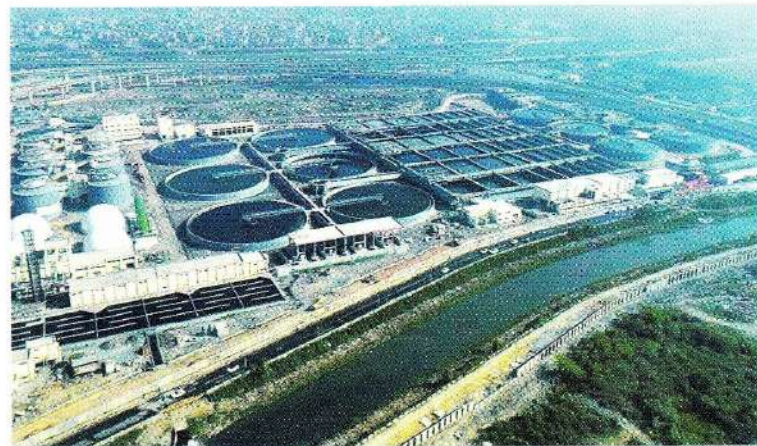
उत्तरी दिल्ली स्थित सीवेज उपचार संयंत्र जो एक दिन में 31.8 करोड़ लीटर सीवेज का उपचार कर सकता है।
