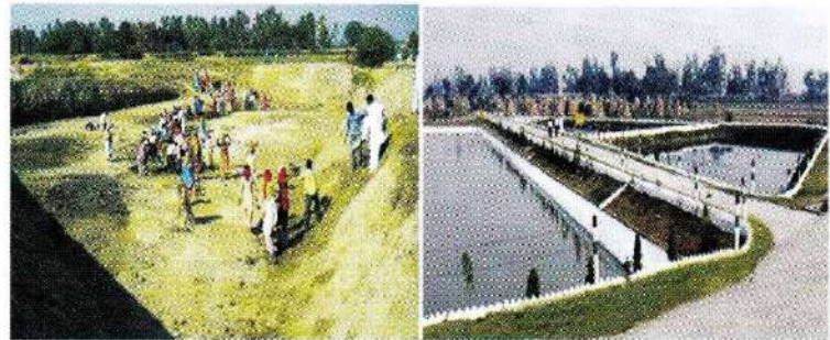
गुरुग्राम जिले के धोलका गाँव में फाइटोरिड प्रणाली से अपशिष्ट जल शोधन
